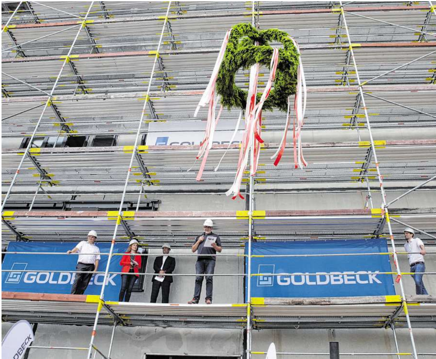
Um kurz nach 12 Uhr mittags wurde die Richtkrone per Kran über dem Rohbau positioniert.
